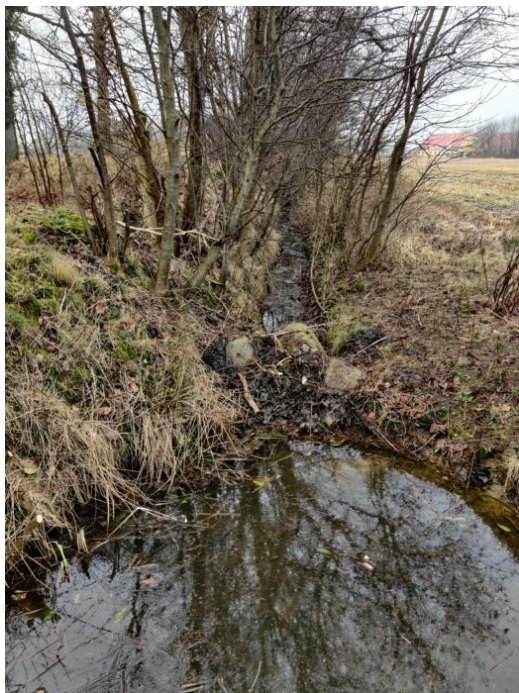
Figur 2: Udløbet til den nordlige grøft.
