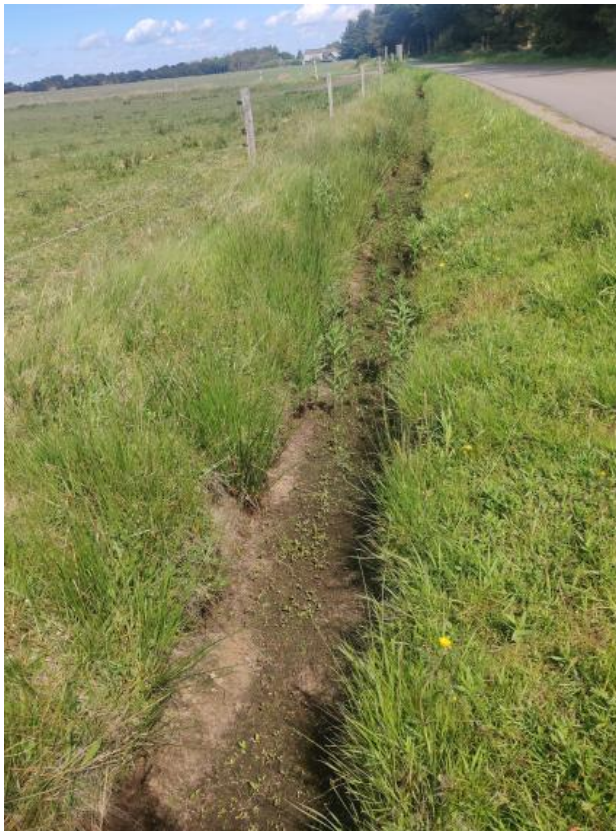
Figur 2: Strækningen opstrøms rørunderføringen.
